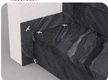
Una vez colocados el peldaño y la tabica, procederemos con la colocación de los zanquines. Alrededor del zanquin siempre debe respetarse una junta mínima de 3 mm.
