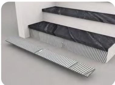
Una vez colocados los peldaños, procederemos a la colocación de las tabicas por el método del doble enculado. Es muy importante que no se toque cerámica con cerámica, dejando una junta mínima de 3 mm entre el peldaño y la tabica. Esta junta se deberá rellenar de material de junta elástica e impermeable.
