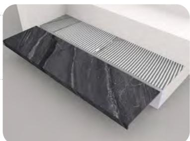
Una vez realizado el replanteo, procederemos a extender el adhesivo en la huella del escalón y peinar con llana dentada. Además extenderemos adhesivo por el reverso del peldaño con el lado liso de la llana. Este tipo de colocación se denomina "doble enculado", y se emplea para que el peldaño quede totalmente macizado y sin huecos en el adhesivo.
