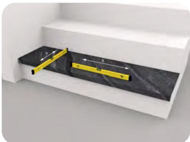
Durante la colocación y antes del fraguado del adhesivo, es muy importante comprobar los niveles de planimetría de eje X e Y. Esta operación se tendrá que hacer en todos los peldaños, por si hay que hacer alguna pequeña corrección.
