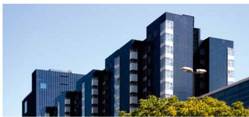
La solución constructiva de envolvente térmica ventilada, o más conocida como fachada ventilada, reviste al edificio por el exterior, apantallando por completo los puentes térmicos, que son los responsables del 30% de las pérdidas de energía de un edificio. Crea una barrera entre el ambiente interior y el exterior del inmueble de manera segura, eficiente y sostenible.
