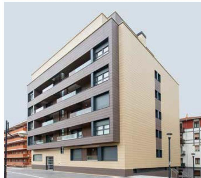
Proyecto llevado a cabo con las piezas FAVEKER® **GA30** en colores beige y marrón. La solidez y robustez de las piezas de espesor 30 mm garantizan las más altas prestaciones y resistencia mecánica. El edificio minimalista destaca sin estridencias y aporta valor y diferenciación al entorno. Esta envolvente térmica beneficia a los propietarios con un importante ahorro en energía, y al entorno gracias a su menor consumo y uso eficiente de la energía.
