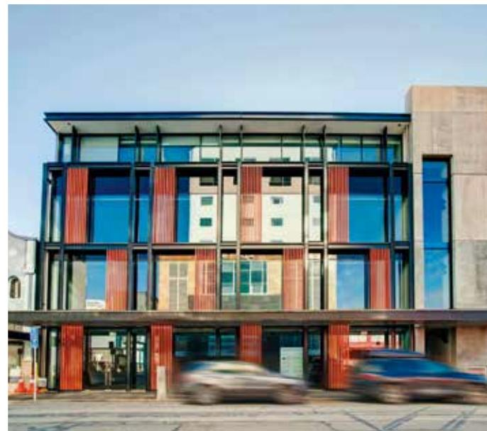
Centro médico en el que se utilizan **lamas** cerámicas para obtener protección a la radiación solar, pero permitiendo el paso de la luz y generando intimidad en ciertas zonas de las estancias. Las **lamas** cerámicas destacan en el conjunto, siendo el elemento diferenciador y destacable del impacto visual del edificio.
